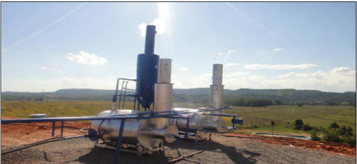
**Figura 02: Exemplo de evaporadora instalada em aterro sanitário**
